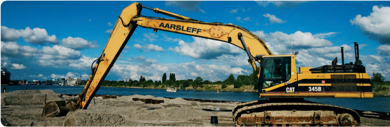
Stemninger fra en af de mange igangværende byggepladser i Nordicom regi
